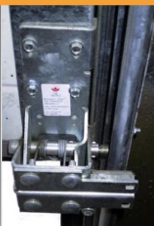
MZL – protection contre la chute de porte en cas de la rupture des câbles
